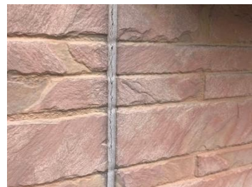
コーキング工事
